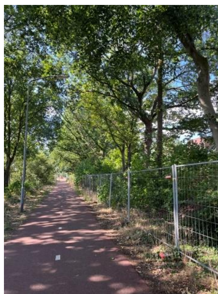
Afbeelding 7. Voorbeeld boombescherming door plaatsen van vaste bouwvakken op rand bosschage.
