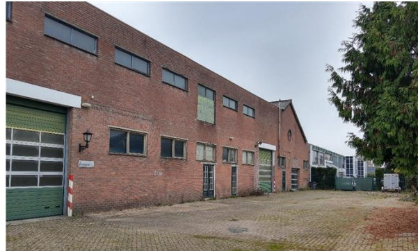
De leegstaande loodsen met het onbebouwde voorterrein
