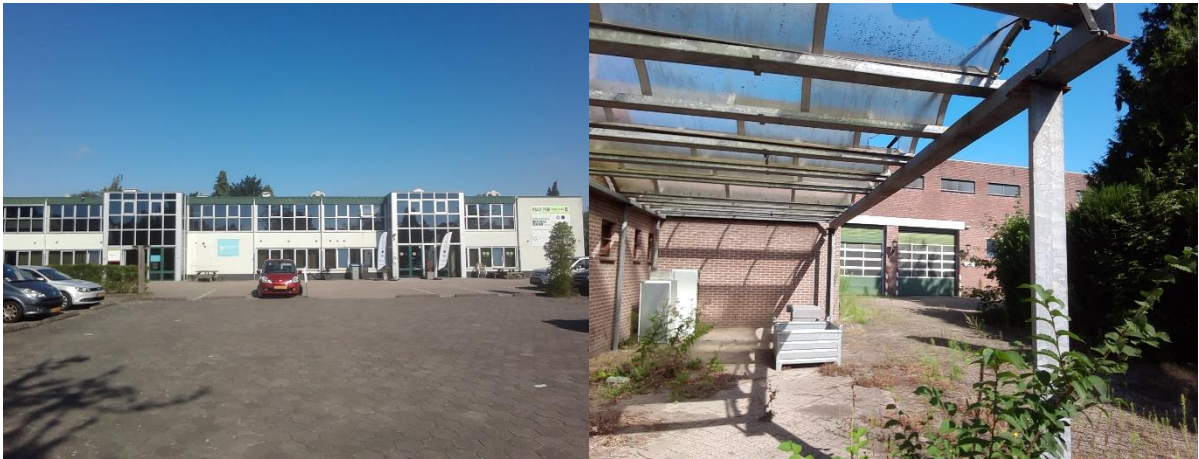
Afbeelding 14 Het plangebied ten tijde van het veldonderzoek. Links uitzicht vanaf boorpunt 1 richting noorden (oostelijk deel plangebied); Rechts vanaf boorpunt 2 richting noorden (westelijk deel plangebied). Bron fotos: Vestigia 23-08-2023.
