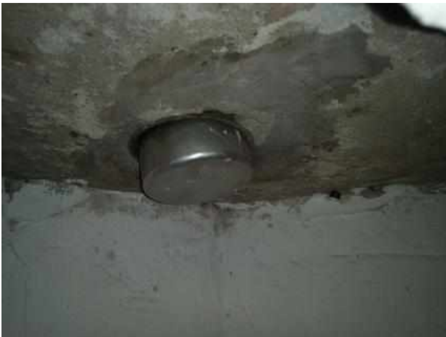
gesloten kachelbuis woonhuizen
