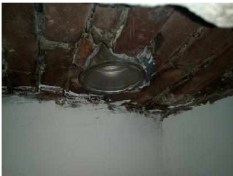
gesloten kachelbuis woonhuizen
