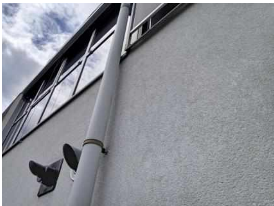
gestucte gevel bedrijfspand Schoolstraat 53
