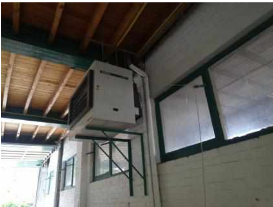
luchtheater Universum asbestvrij
