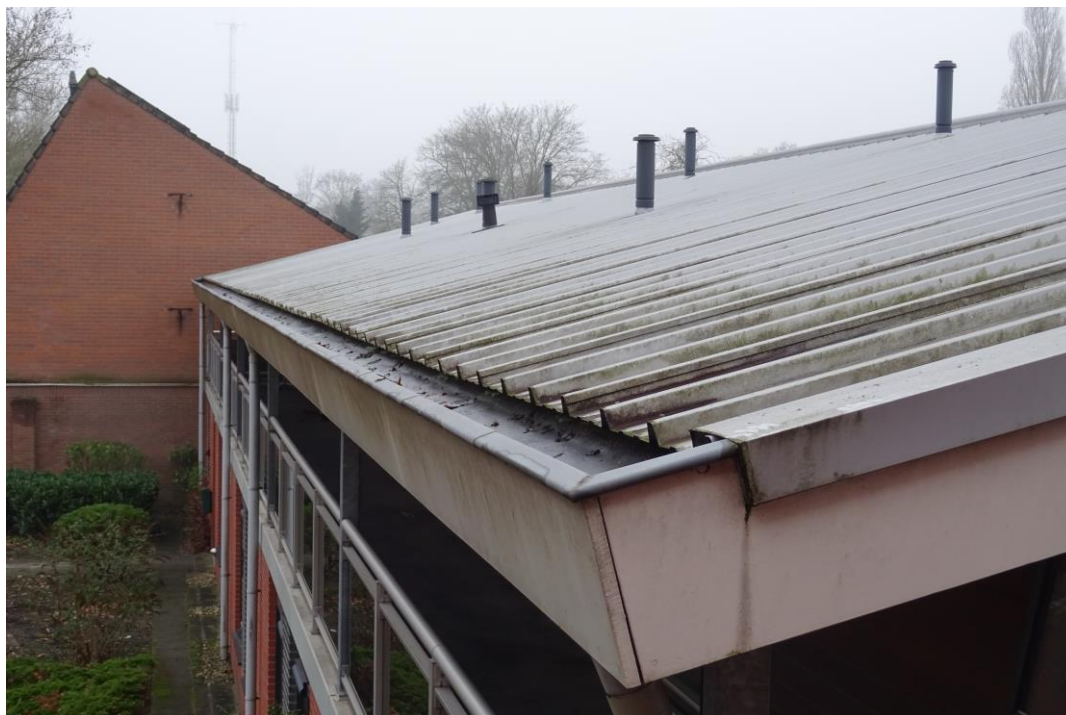
Afbeelding 7: Het aanwezige dak is niet geschikt bevonden voor vaste- rust en verblijfplaatsen voor huismussen. Bron: Rik Bijvelds. Datum: 01-02-2021
