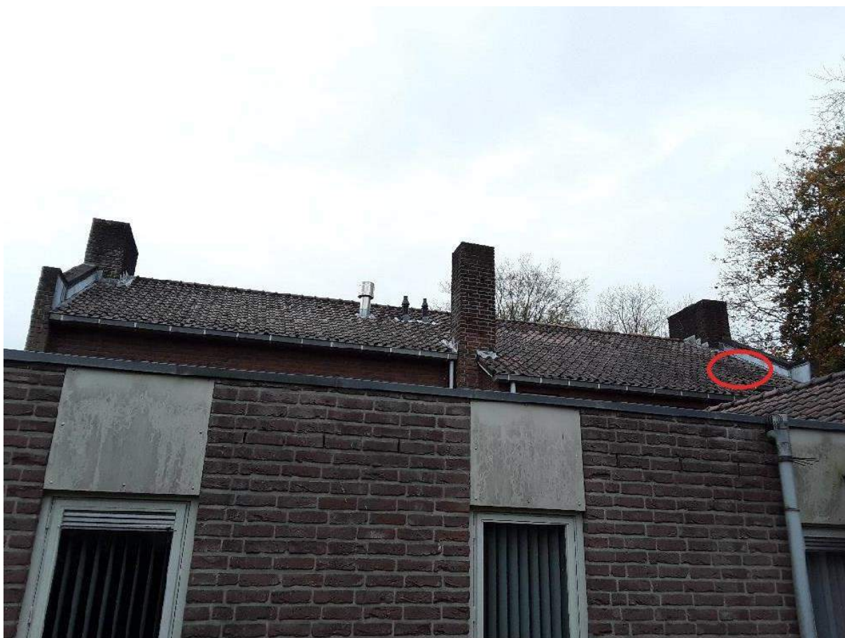
Dak achterzijde met verblijfplaats Gewone dwergvleermuis
