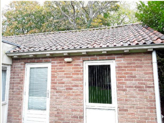
Gevel met open stootvoegen
