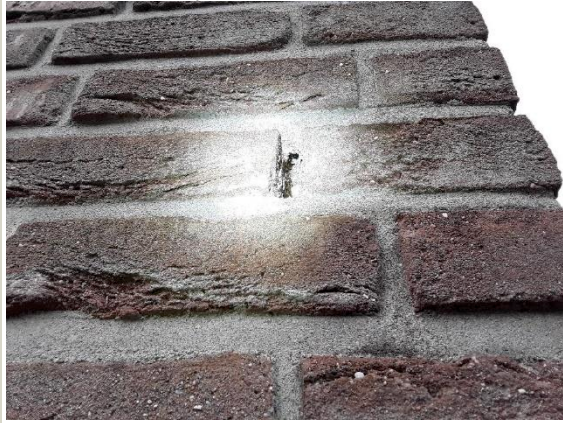
Muur met open stootvoegen
