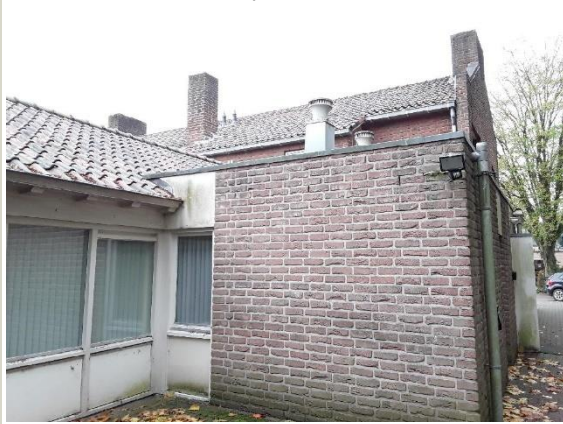
Muur met open stootvoegen
