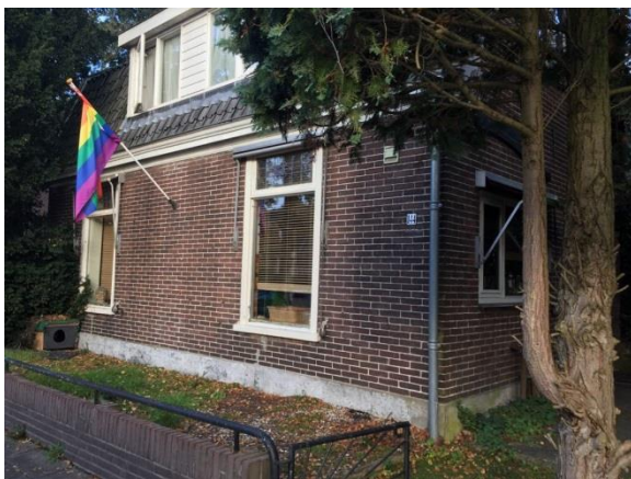
Figuur 7: Overzichtsfoto bebouwing
