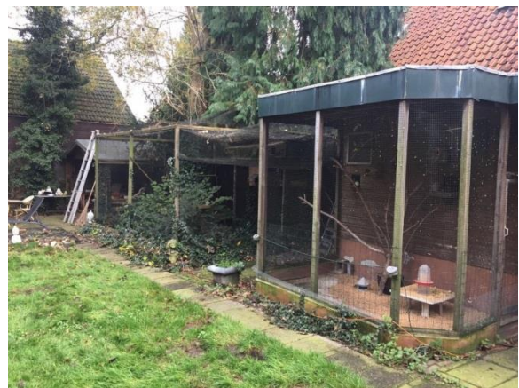
Figuur 8: Overzichtsfoto bebouwing
