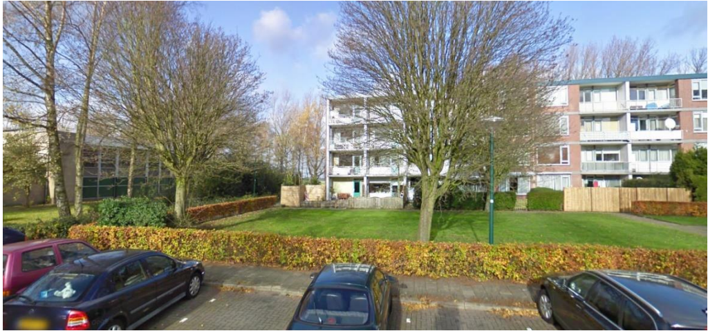
Bestaande situatie zuidzijde bestemming 'tuinen' (bron: google maps streetview)
