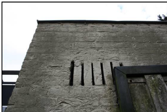
Afbeelding 5: Ventilatie openingen in spouwmuur
