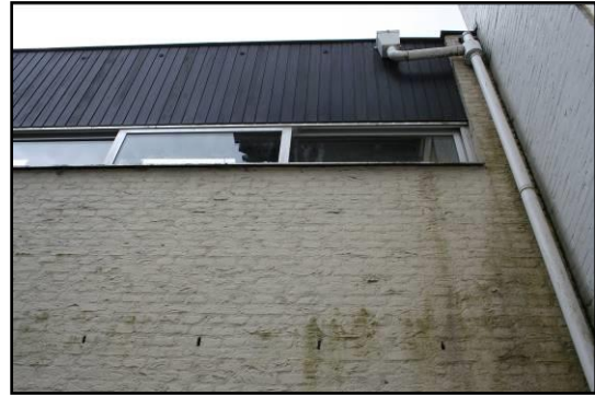
Afbeelding 8: Ruimtes onder de houten beplating en tussen de twee muren van de woningen
