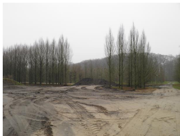
Figuur 3. Deel van het terrein waar zand is aangebracht ten behoeve van de nieuwe parkeervakken.
