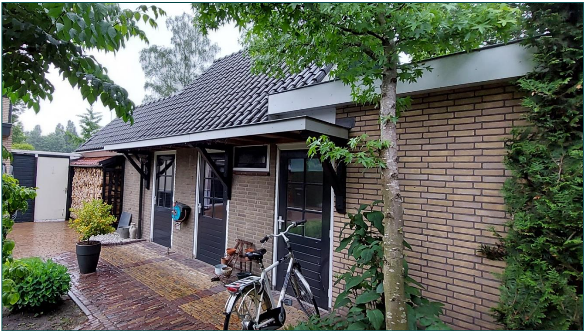
Figuur 4 Het zuidelijke deel van de garage betreft een nieuwe aanbouw. Enkel dit deel beschikt over een spouw.
