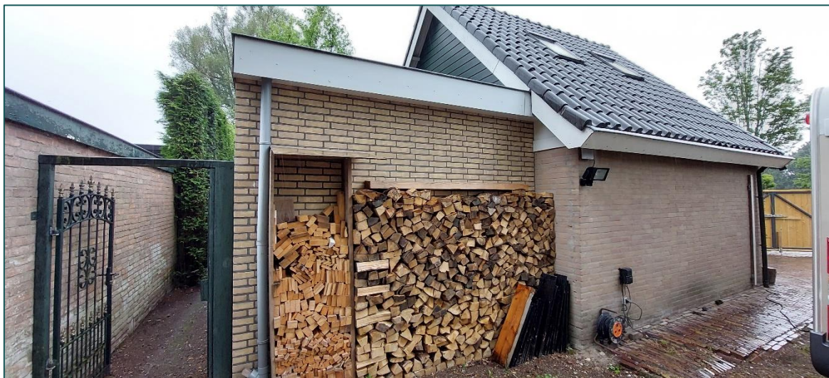
Figuur 3.1 De overgangen tussen gevels, betimmeringen en dakranden zijn allemaal geïnspecteerd en bleken zeer nauwsluitend bevestigd te zijn.
