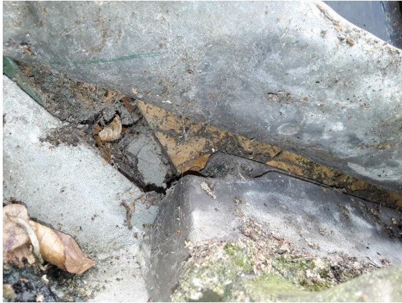
Houten dakbeschot onder loodslabben
