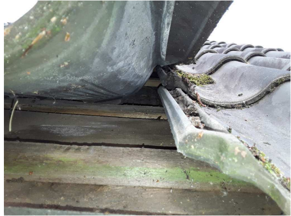
Houten dakbeschot onder pannen
