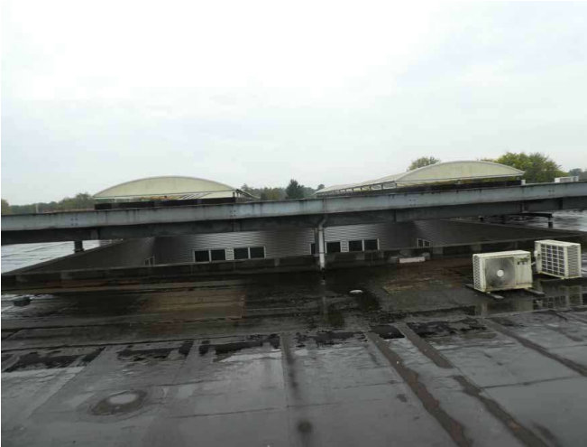
Figuur 18 Overzicht dak
