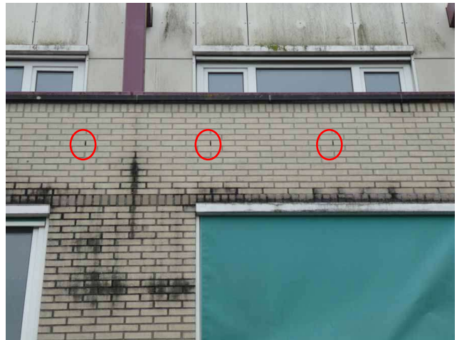
Figuur 13 Geen ruimte metalen daklijst
