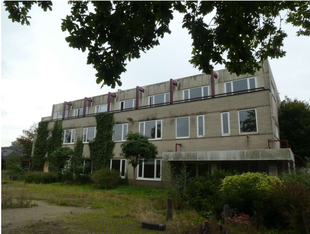
Figuur 3 Af te breken kantoorpand
