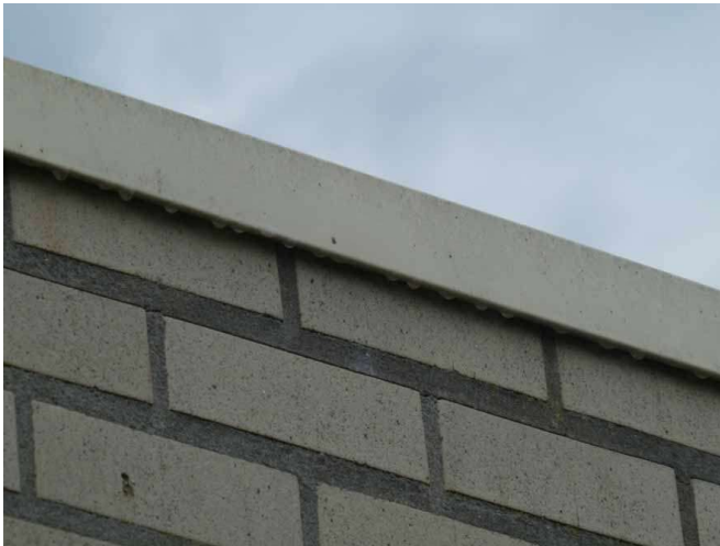
Figuur 17 Detail metalen daklijst
