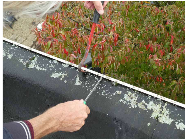
Figuur 13 Geen ruimte metalen daklijst
