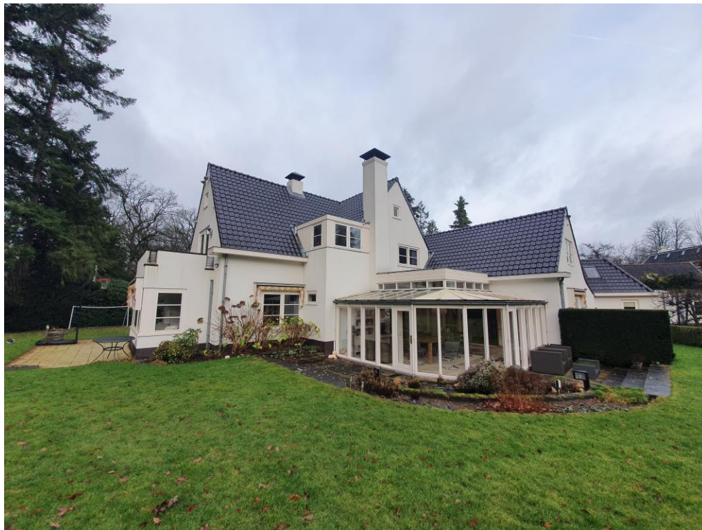
Figuur 2 De woning heeft verschillende kopgevels met kierende kantpannen waar vleermuizen toegang tot de dakruimte kunnen vinden.
