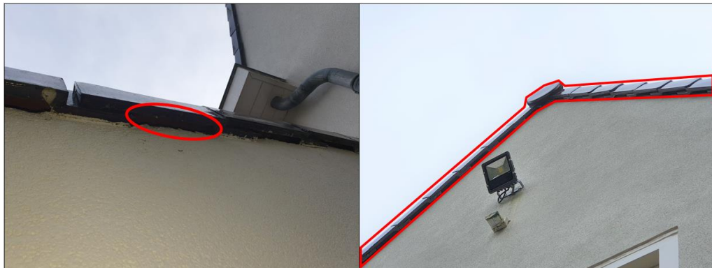
Figuur 4 Rood omcirkeld de plaatsen waar vleermuizen toegang kunnen krijgen tot de dakruimte en mogelijk tot de spouw
