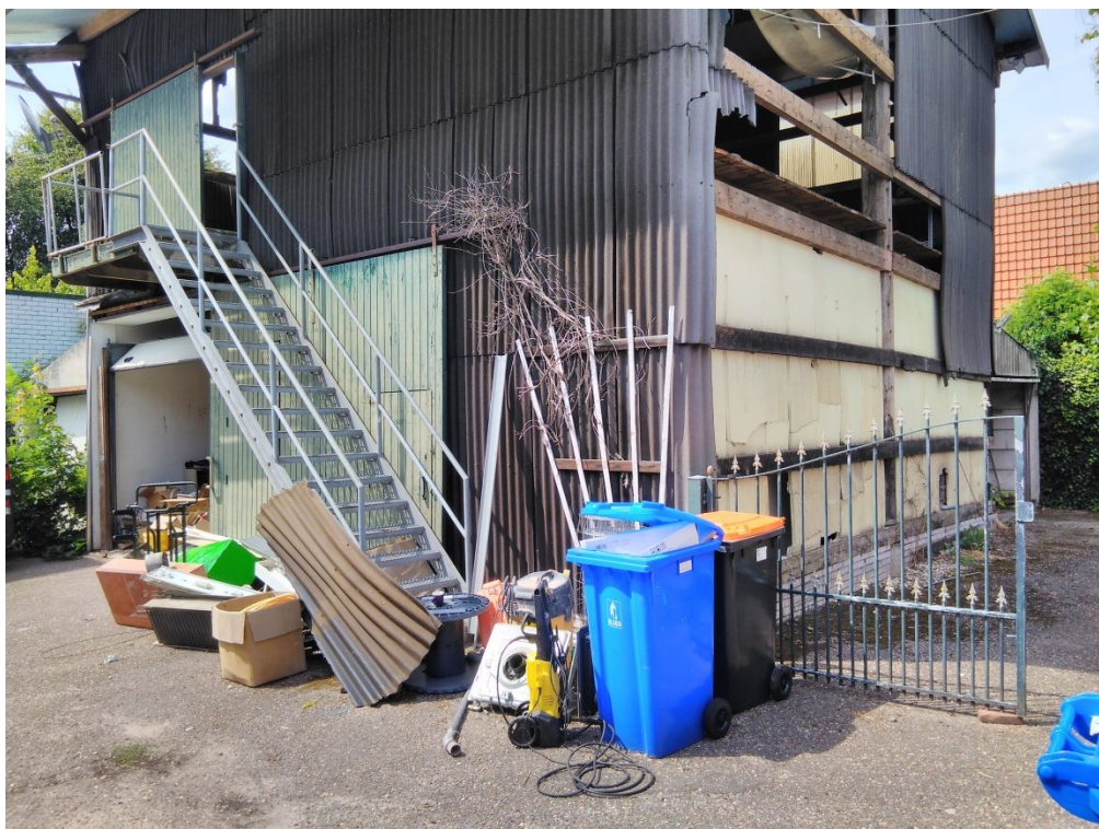
Foto 2: overzicht schuur (voorgenomen locatie garage/berging)
