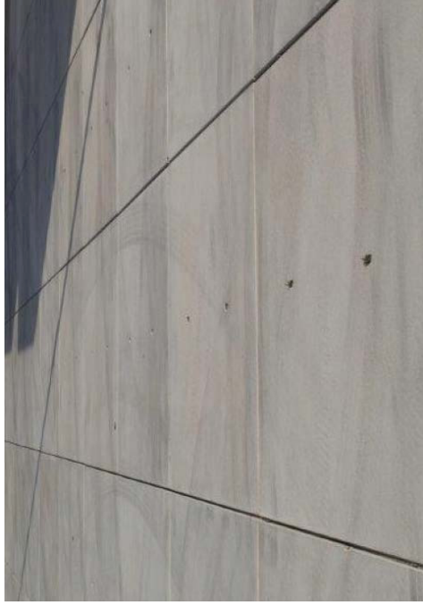
Stelconplaten 2x2 meter)
