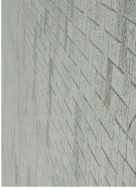
Betonstraatstenen, keiformaat, grijs, keperverband (t.p.v. kabels en leidingen)
