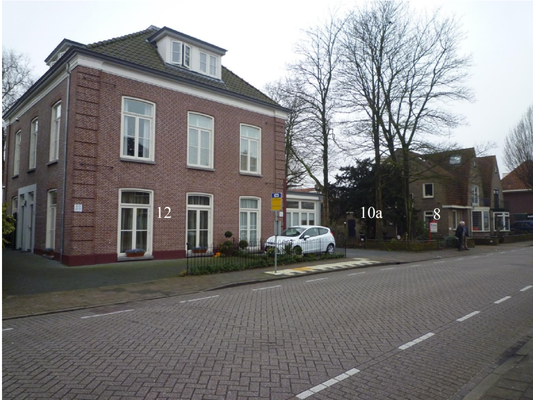
Belendingen Eemstraat 12 - 10a - 8 met de tussenliggende bomen
