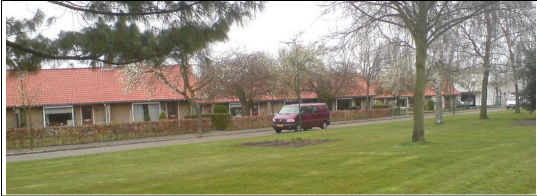
Afbeelding 3: Bestaande bebouwing (vanuit het zuidoosten).
