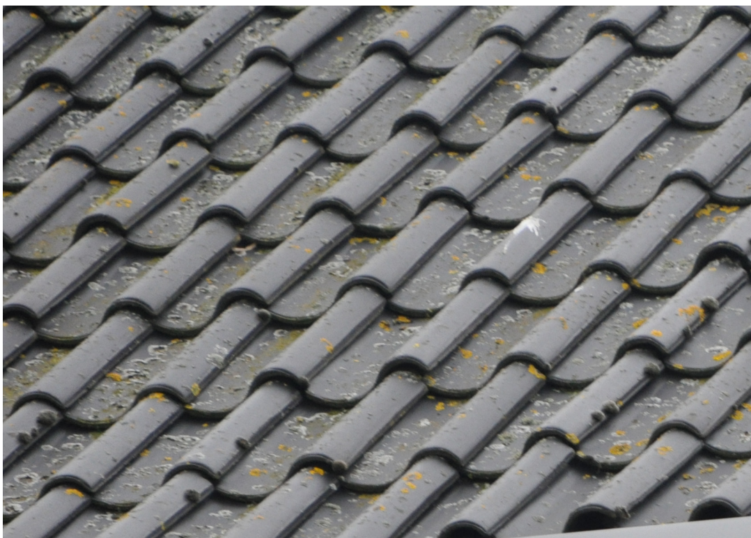
Geschikte in- en uitvliegopeningen voor vleermuizen in het woonhuis.
