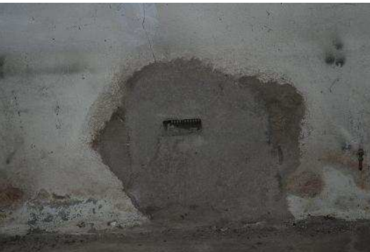
Enkel steens muur van loods met ventilatierooster.
