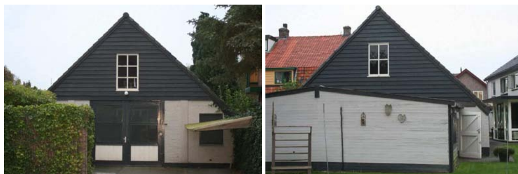
Figuur 2a. Foto's van de respectievelijk voor- en achterzijde loods.
