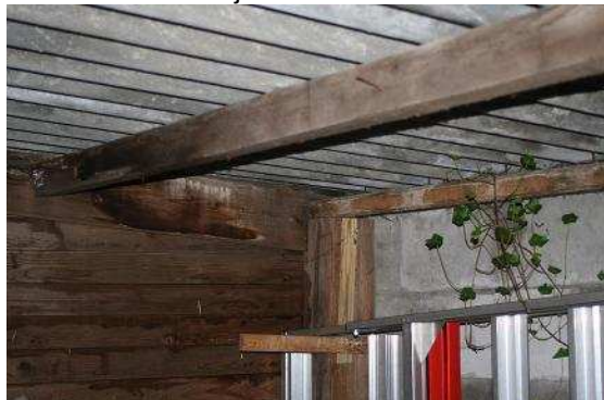
Aanbouw achterzijde loods.
