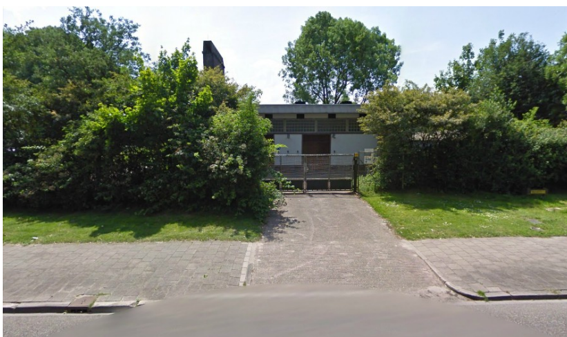
Figuur 2: GOS gezien vanaf Drakenburgerweg (bron: Google Streetview)
