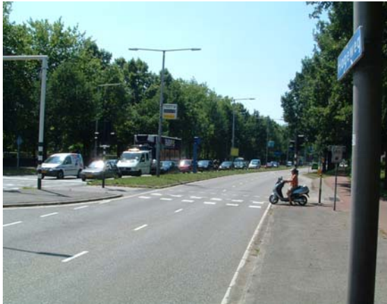
Afbeelding 1: Hogeweg vanaf A28 ter hoogte van de Operaweg
