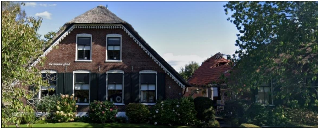
Figuur 4 Bedrijfswoning en naastgelegen schuur
