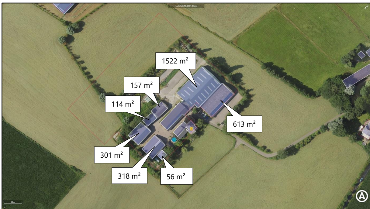
Figuur 3. Luchtfoto erf met de te slopen bebouwing aan de Boelenhoefseweg 3 (bron: Street Smart)
