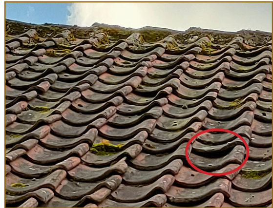
Afbeelding 5: Het pannendak van het truckerscafé biedt mogelijkheden voor vleermuizen; o.a. door toegangsopeningen onder scheefliggende dakpannen.
