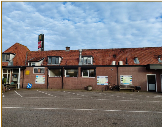
Afbeelding 4: Zicht op het truckerscafé vanaf het zuiden. Het pand heeft mogelijkheden voor huismus en vleermuizen onder dakpannen en aanvullend voor vleermuizen achter open stootvoegen.
