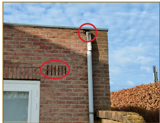
Afbeelding 7: Het woonhuis is mogelijk geschikt voor vleermuizen door aanwezigheid van openingen langs dakrand, achter regenpijpen en via open stootvoegen.
