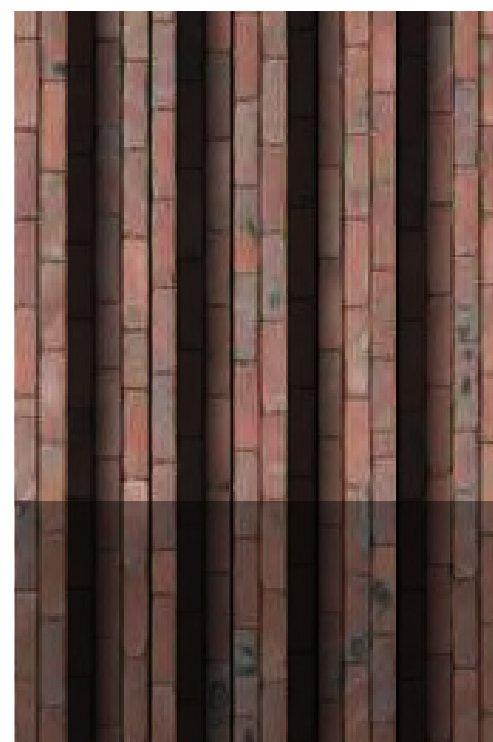
bijzonder metselwerkuitvoering in plint
