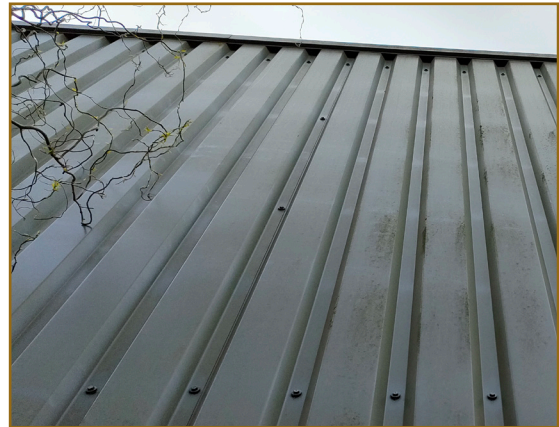
Afbeelding 5: Het uit te breiden bedrijfspand biedt geen mogelijkheden voor beschermde soorten. Dakranden sluiten rondom goed aan en gevelbekleding bestaat uit gladde damwandplaten.
