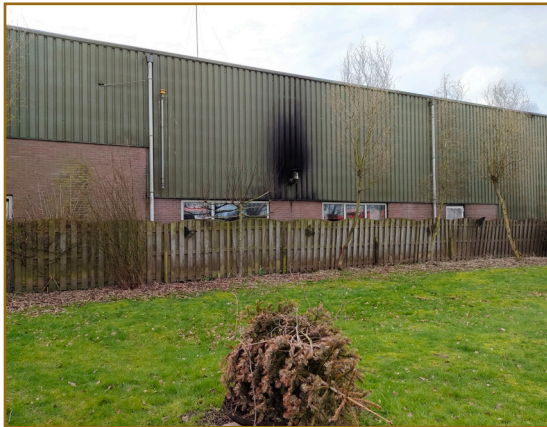
Afbeelding 4: Zicht op het naastgelegen uit te breiden bedrijfspand vanaf het noorden. Het bouwvlak van de uitbreiding bevindt zich op het gazon op de voorgrond.
