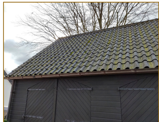
Afbeelding 9: De dakpannen langs de noordzijde van de schuur waren volledig te inspecteren; hier zijn geen nesten waargenomen.
