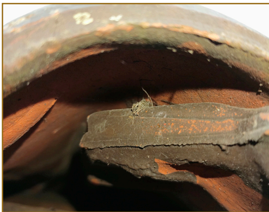
Afbeelding 6: Zicht onder een van de dakpannen. Met een sterke zaklamp was de volledige onderste rij te inspecteren en hier zijn geen (resten van) nesten aangetroffen..
