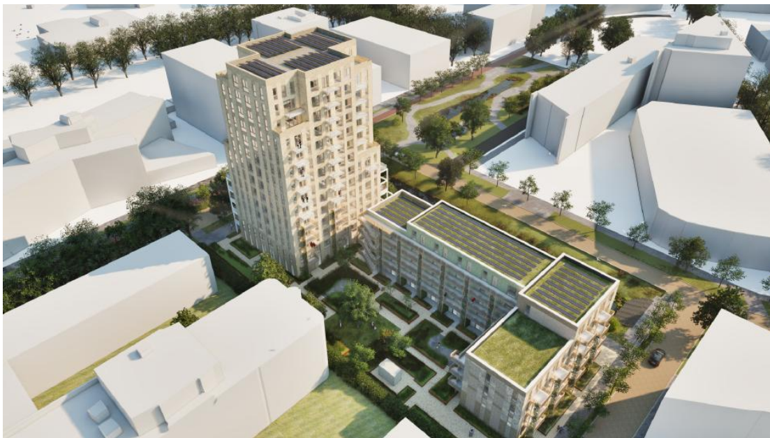
Figuur 2-3 Aanzicht vanaf Printerweg (bron: AGNova Architecten)
