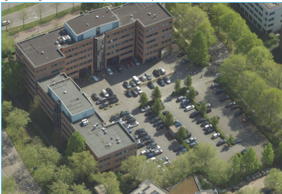
Figuur 5: Huidige situatie achteraanzicht (bron: Streetsmart)
