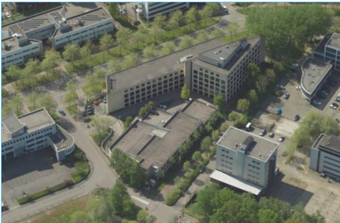
Figuur 5: Huidige situatie achteraanzicht (bron: Streetsmart)
