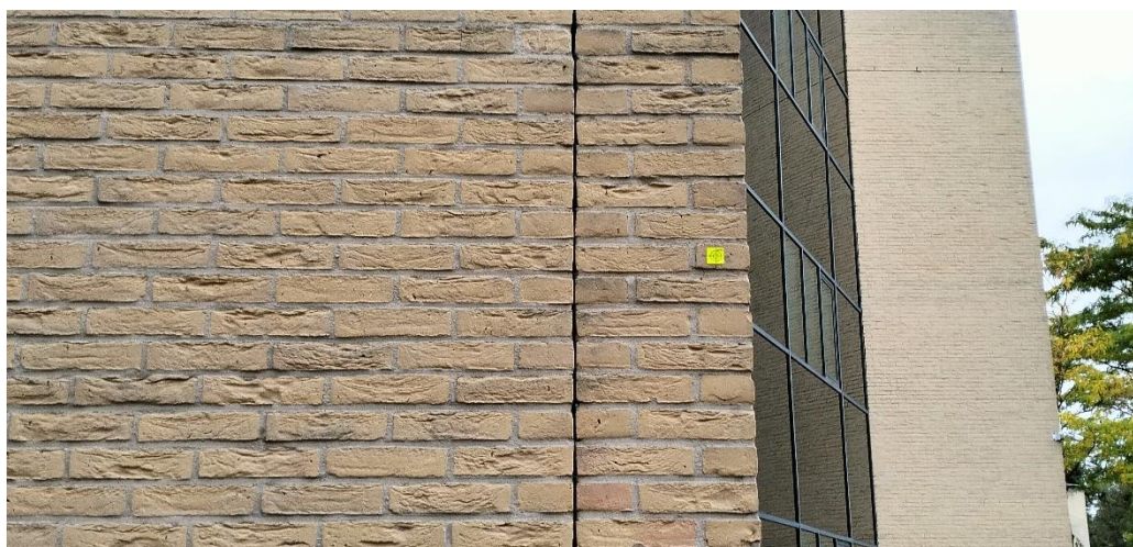
Figuur 5: Open dilatatievoeg Computerweg 8 Amersfoort (Laneco, 2024).
