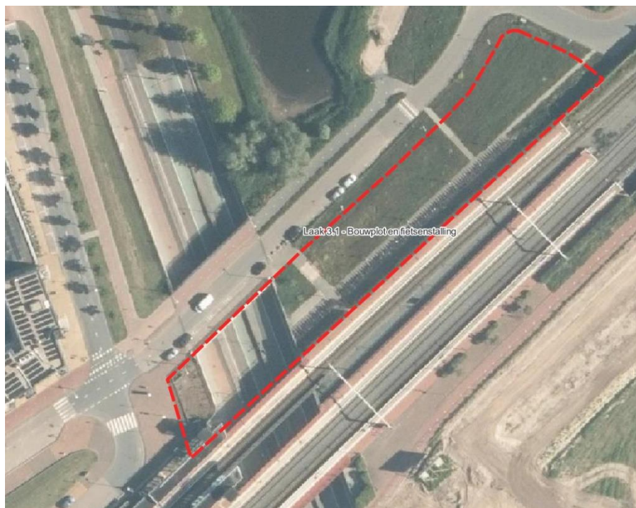
afbeelding 26: locatie nieuwe gebouwde fietsenstalling (bron: pdok.nl luchtfoto 2022)
