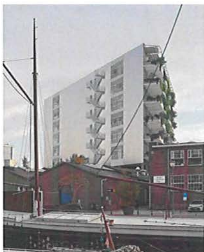
Afbeelding 2: gevelaanzicht noordoostgevel van kamer 2
