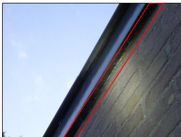
Fig. 2.4 (Zeer) kleine spleet bij boeidelen opstal 1, met spinrag (bron: FF Solutions)
