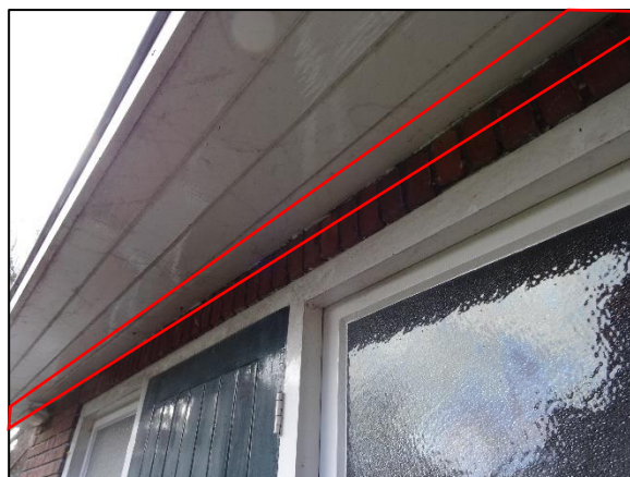
Fig. 2.7 Dakoverstek, zonder spleet, met vulmateriaal (bron: FF Solutions)
