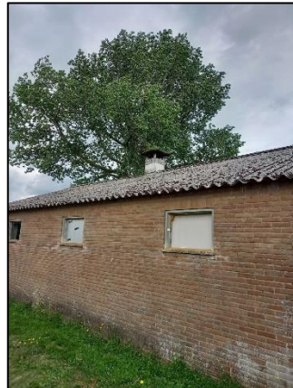
Fig. 2.6, Gebouw 3 (bron: FF Solutions)
