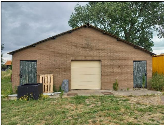
Fig. 2.5, Gebouw 3 (bron: FF Solutions)
