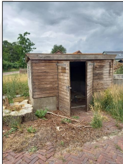
Fig. 2.11, Overig bijgebouw (bron: FF Solutions)
