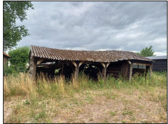
Fig. 2.10, Gebouw 6 (bron: FF Solutions)
