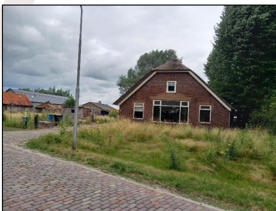
Fig. 2.2, Voorzijde gebouw 1 (bron: FF Solutions)
