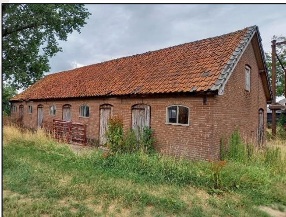
Fig. 2.7, Gebouw 4 (bron: FF Solutions)
