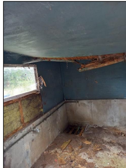
Fig. 2.12, Binnenzijde overig bijgebouw (bron: FF Solutions)
