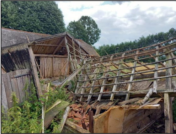
Fig. 2.4, Gebouw 2 (bron: FF Solutions)
