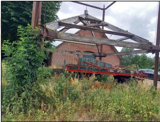
Fig. 2.9, Gebouw 5 (bron: FF Solutions)
