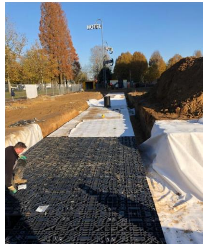
voorbeeld infiltratie Bastion Geleen
