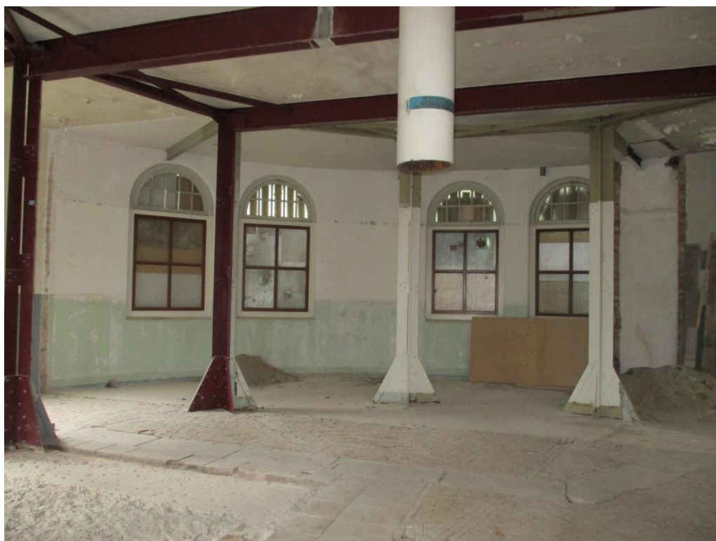
Figuur 2 De binnenzijde van de watertoren (begane grond).
