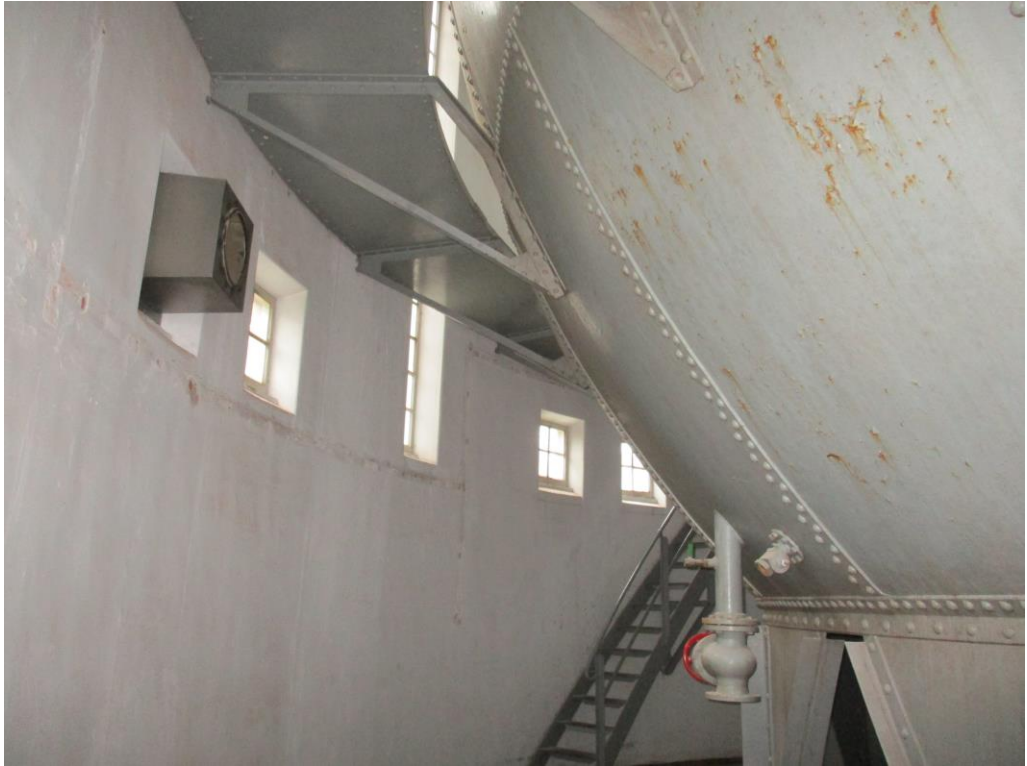
Figuur 3 De metalen watertank binnen in de watertoren.
