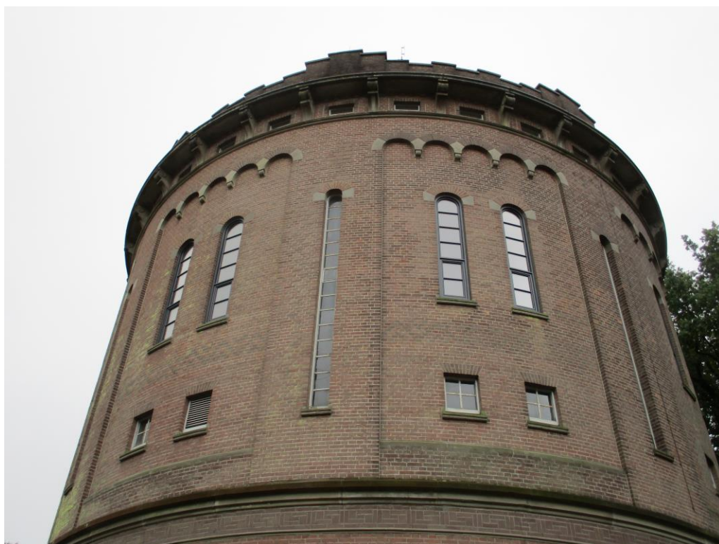
Figuur 1 De planlocatie is gelegen aan de Utrechtseweg 174 te Amersfoort en bestaat uit een perceel met daarop een 17 m hoge watertoren opgetrokken uit gemetselde muren met een plat bitumen dak.
