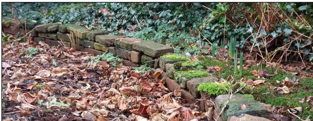
Figuur 5.8 Lage stapelmuur van oude bakstenen. Foto: Martin Heinen, Ecogroen.
