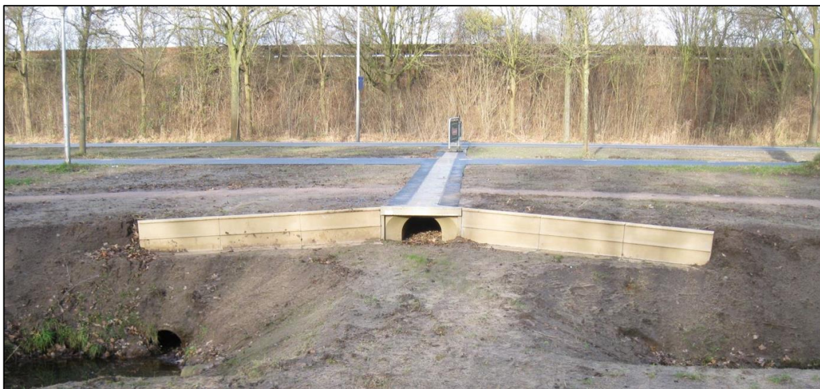
Figuur 7: Rechthoekige faunatunnel op gelijke hoogte met het asfalt.
