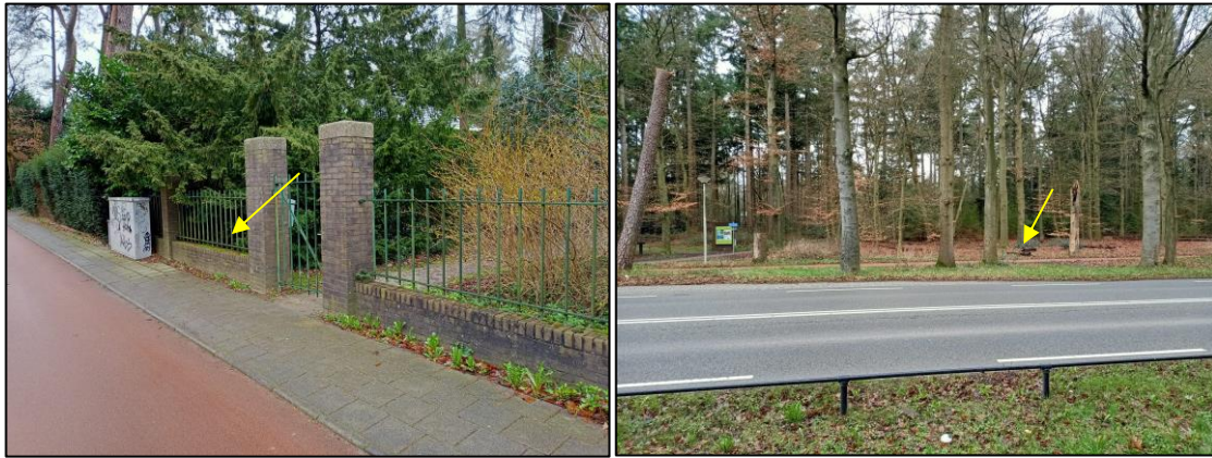
Figuur 2 & 3: Locatie gezien vanaf het fietspad aan de oostzijde van de weg. De gele pijlen wijzen de uitgangen van de passage. De ingang aan de Blom-kant komt achter de muur te liggen.
