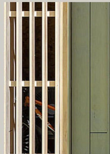
warmtepomp weggewerkt in opengewerkte gevel (referentie voor het Buitenhuis)
