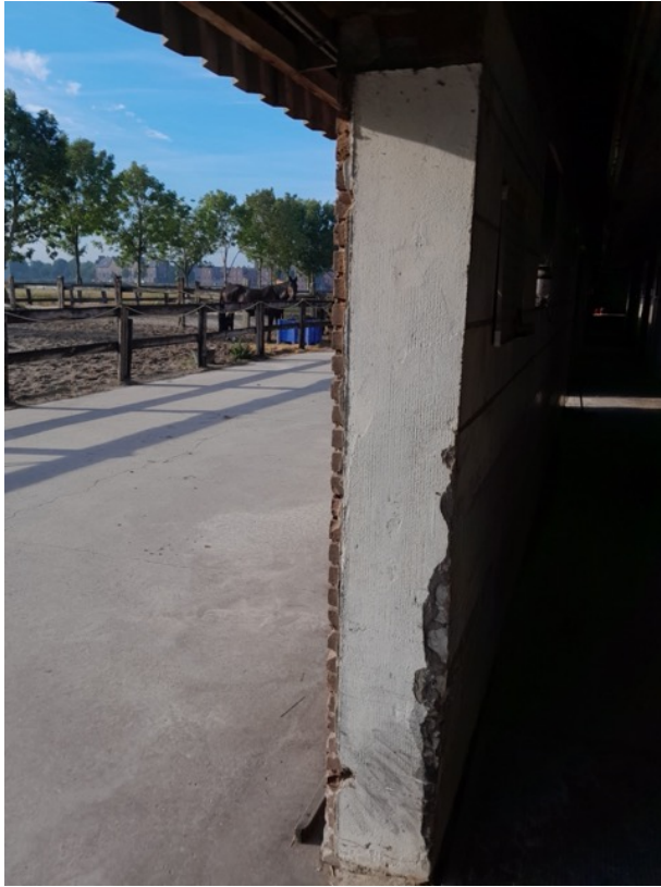
Figuur 5. Grote schuur. Daar waar sprake is van een dubbele muur, is de spouw ontoegankelijk.
