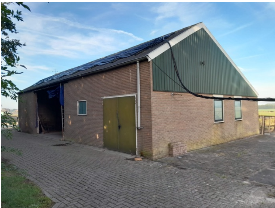
Figuur 4. Kleine schuur waarvan de sloop is voorzien.
