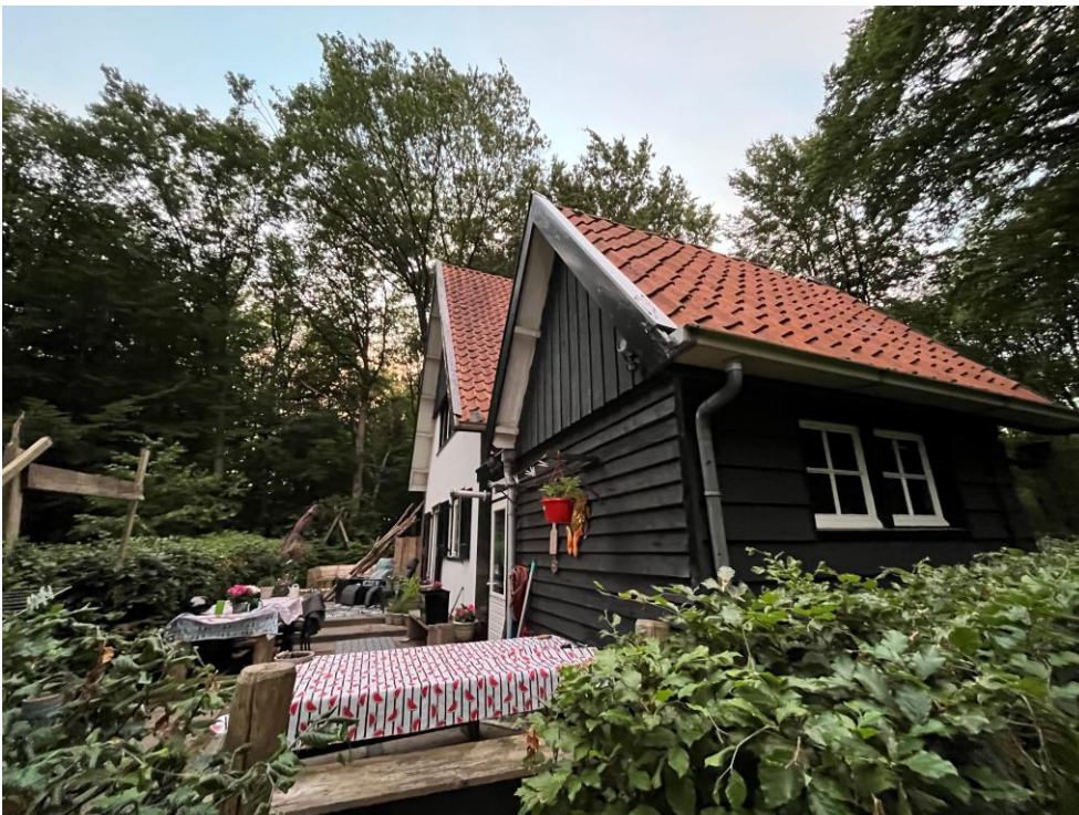
Figuur 4. Beeld van de achterzijde van de woning (zuidzijde) met de aangebouwde garage.
