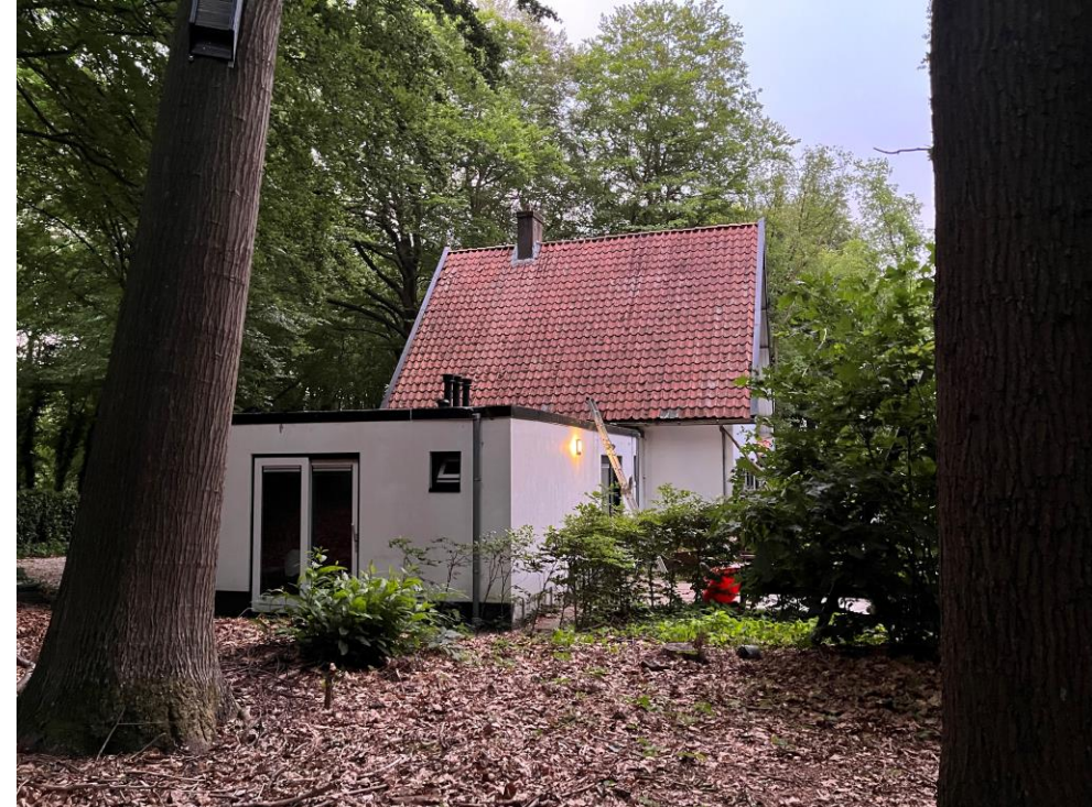
Figuur 5. Beeld van de rechterzijde van de woning met de uitbouw (oostzijde).
