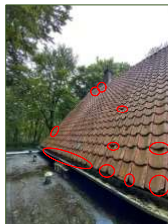
Fig. 2.4 Dakvlak met kieren (bron: FF Solutions)
