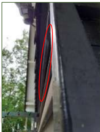
Fig. 2.5 Kieren tussen betimmering (bron: FF Solutions)
