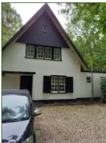
Fig. 2.6 Voorkant woning (bron: FF Solutions)
