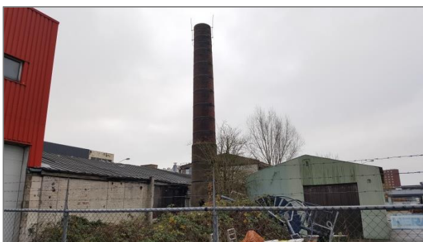
Afbeelding 3.7 | Oude schoorsteenpijp en verouderde bedrijfspanen en loodsen
