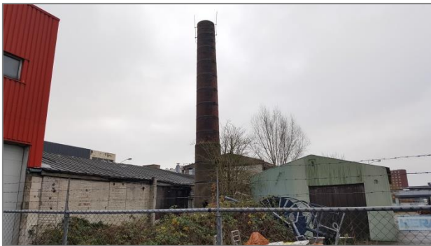
Afbeelding 2.7 | Oude schoorsteenpijp en verouderde bedrijfspanen en loodsen
