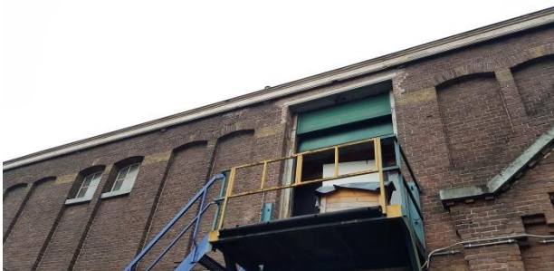
Afbeelding 5.2 | Boeiboord en kieren die kunnen dienen als verblijfplaats
