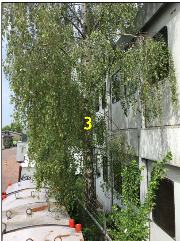
Afbeelding 12: Berk zeer dicht bij huidige (te slopen) gebouw;
