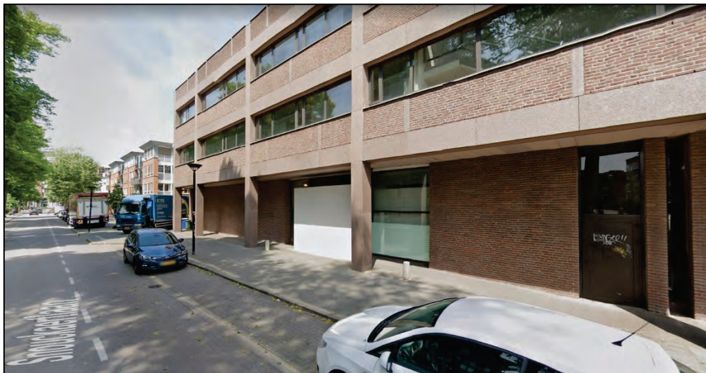
Afb. 3.2.2.2 – Zij aanzicht van het pand aan de Utrechtseweg 1, genomen vanaf de Snouckaerlaan. Bron: Google Streetview.
